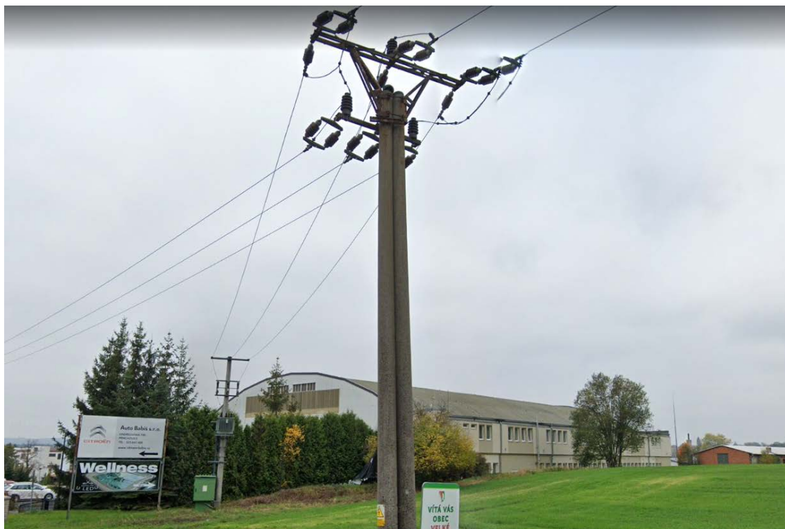
Odbočka vedení VN pro stadion. V pozadí stožárový transformátor s hlavní rozvodnou skříní.
