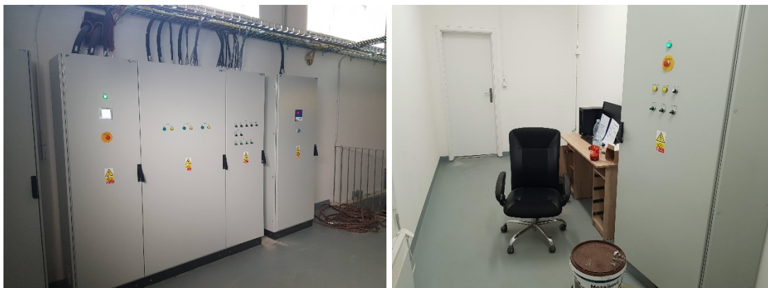
Vlevo hlavní NN přívod do elektroměrové rozvodnice odběrného místa C45d. Vpravo dispečerské řízení, hlavní ovládací panel.
