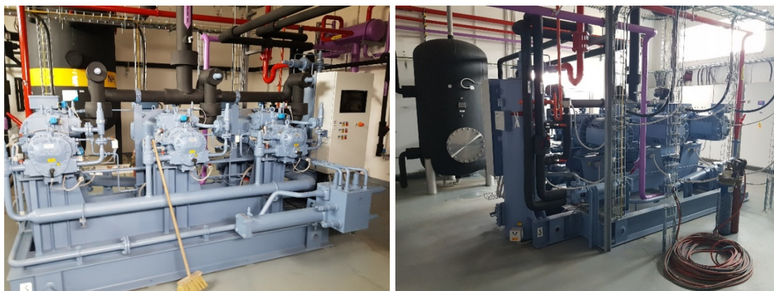
Strojovna chlazení, vlevo trojice kompresorů, vpravo v pozadí zásobník čpavku.
